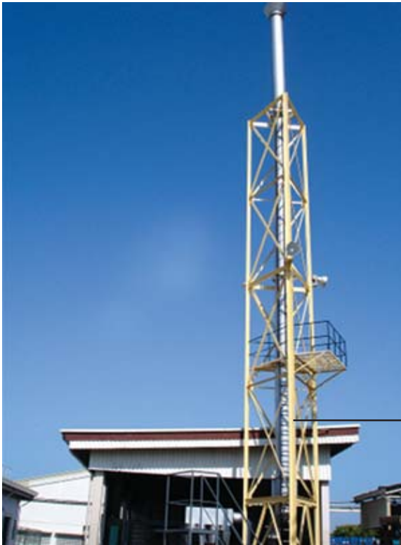
စွန့်ပစ်ပစ္စည်းအမှန် အမှားများကို မီးရှို့ ဖျက်စီးသောမီးရှို့စက် (Incinerator)
